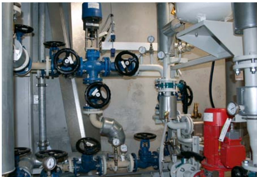
Třífázový regulační ventil, sedlové uzavírací ventily Typ 471 a klapky VZAV s ruční pákou.
