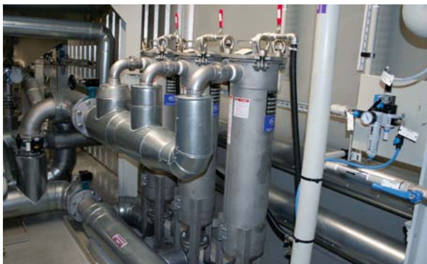
Ruční klapky VZAV s převodovkami pro regulaci, kulové kohouty Typ 707 a úpravná jednotka Festo.
