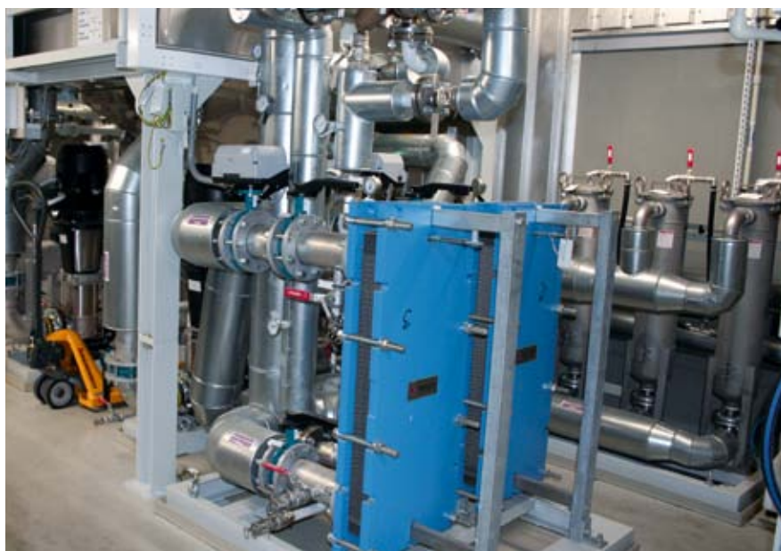
Ruční klapky a klapky VZAV osazené regulačními elektropohony GEMŮ pro regulaci teploty v lázni.
