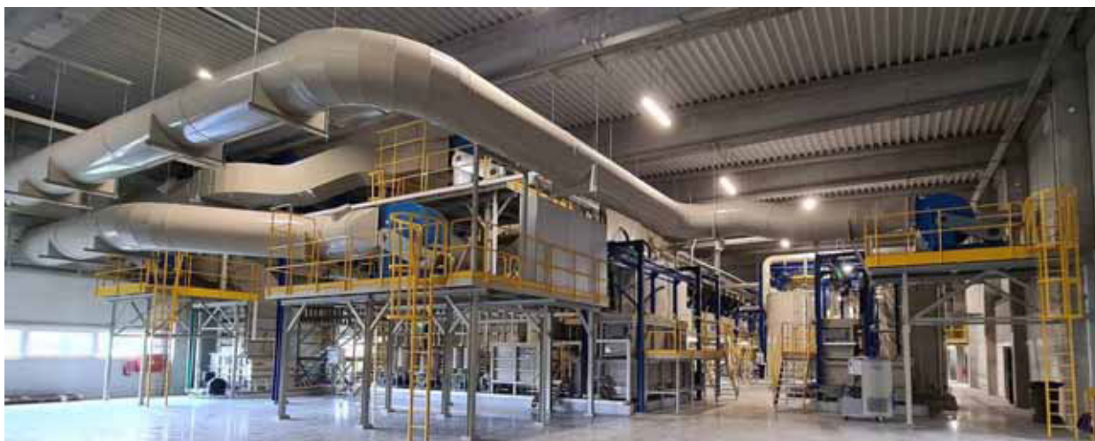
Obr. 1: Linky v patře haly povrchových úprav
